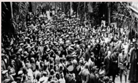
Un moment de la cerimònia de benedicció i col·locació de la primera pedra del futur edifici, en presència dels plànols del projecte esbossat per l'arquitecte Lluís Planas Calvet, el dimarts de Festa Major 17 de setembre de 1924 (AHC, Fons Planas-Montanyà)
